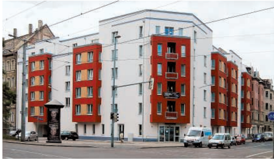
Der neu erbaute Seniorenwohnstift „Am Thonberg“ an der Ecke Täubchenweg/Köbisstraße. Fotos: Armin Kühne
